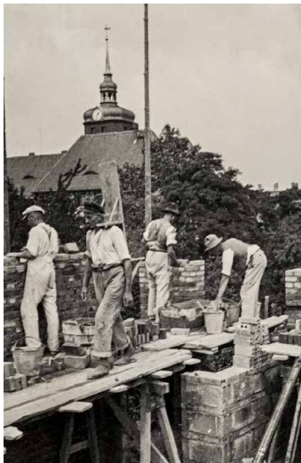
Bauarbeiten am Feierabendhaus, das im Jahr 1933 eingeweiht wurde
