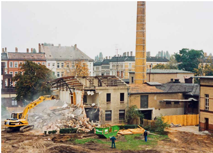
Abrissarbeiten – hier am Technikgebäude und Heizhaus – in Vorbereitung für den schrittweisen Neubau des Krankenhauses in den 1990er-Jahren
