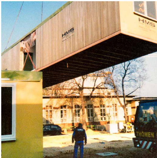
Während der zahlreichen Baumaßnahmen waren einzelne Bereiche des Krankenhauses vorübergehend in Modulen untergebracht – so etwa der OP und einige Krankenstationen.
